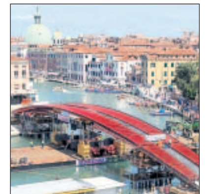
Vorerst steht nur das blanke Stahlgerüst, nun folgt das Glas. Foto: dpa
